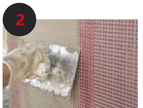
2 Aufbringen einer Armierungsschicht
