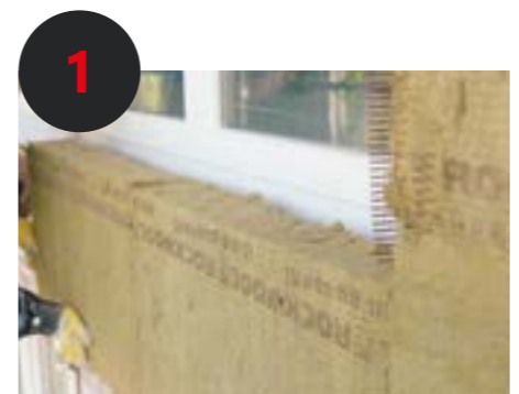
1 Ansetzen der Dämmplatten an die Fassade
