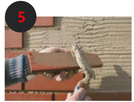
5 Auftragen des Klebers auf das Riemchen (Buttering-Floating-Verfahren)
