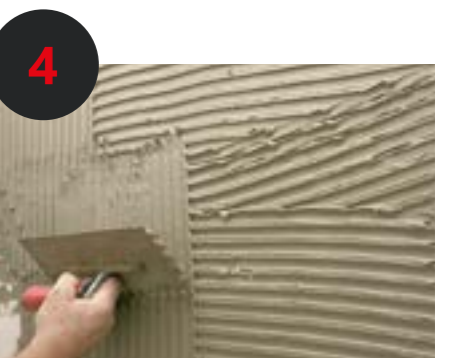
4 Auftragen des Klebers
