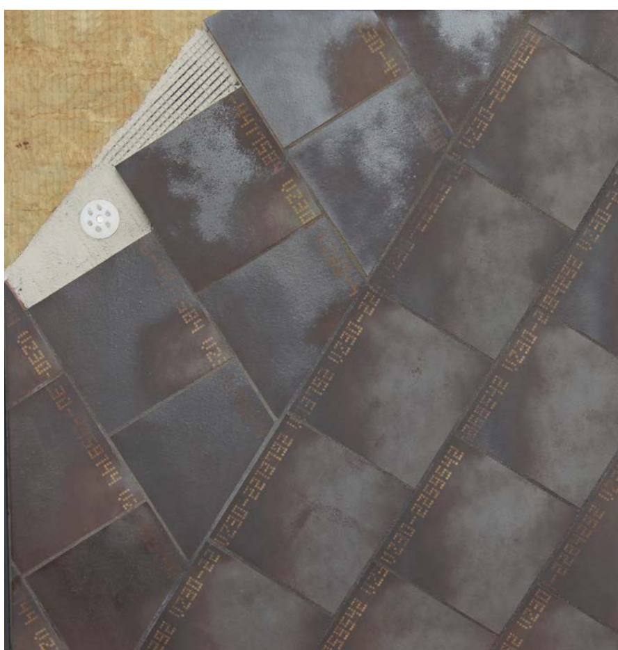
Keramikfassade auf WDV-System
